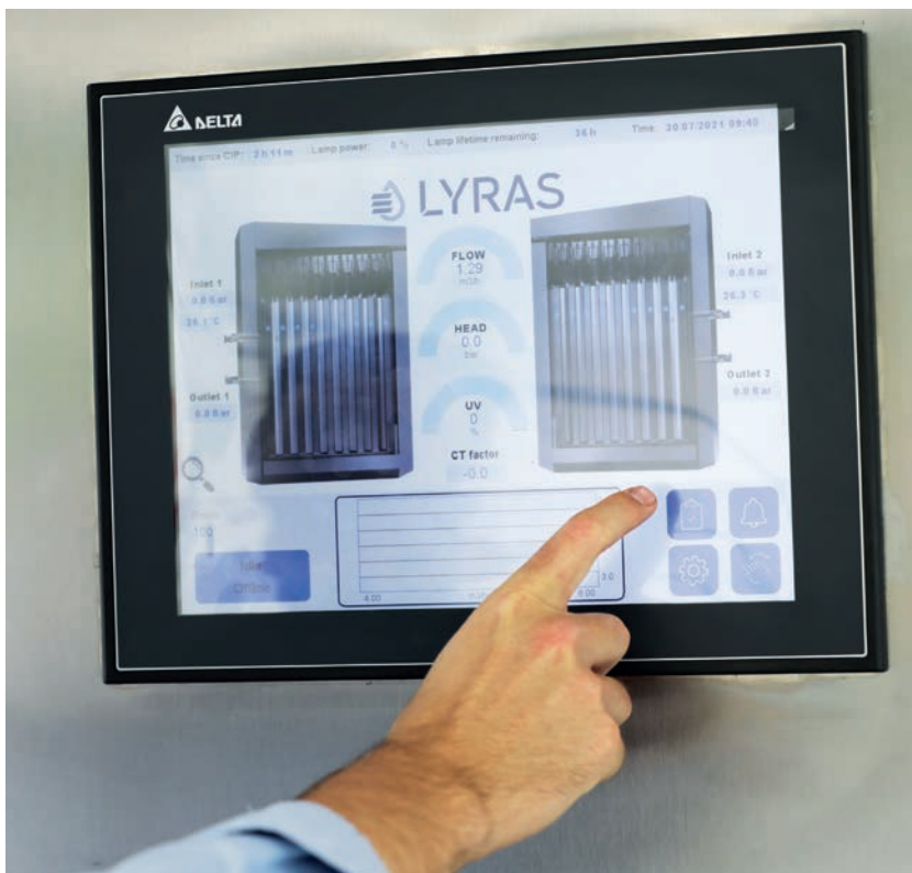
Novozymes' nye raslyseringsanlæg fra Lyras vil erstatte nogle af de arbejdskrævende filtreringsprocesser, der før har givet fysiske belastninger for virksomhedens ansatte i form af manuel håndtering af filtre.
